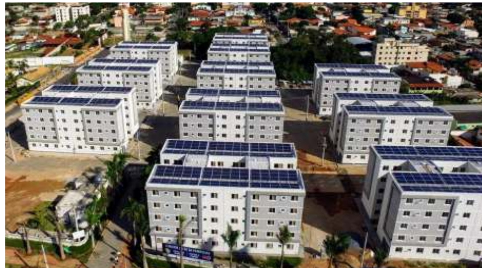
Sistema em condomínio residencial, Belo Horizonte (MG).
